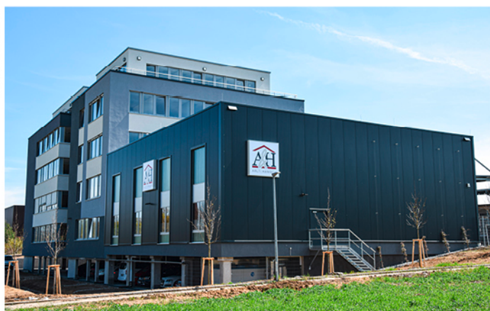
Blick auf das moderne Firmengebäude von Arlt &amp; Hanisch
